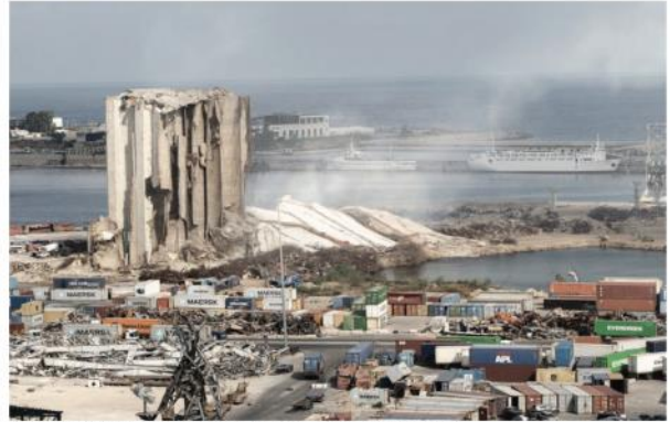
Nouvel effondrement des silos au port de Beyrouth, le 23 août 2022. Photo Mohammad Yassin
