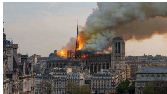
Propagation de l'incendie à la toiture
