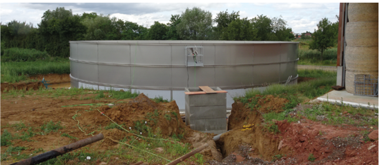
Réservoir semi-enterré de stockage de digestat
